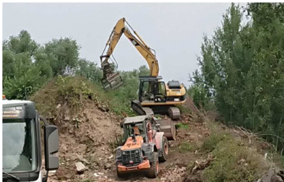
Baubeginn in Giesensdorf
