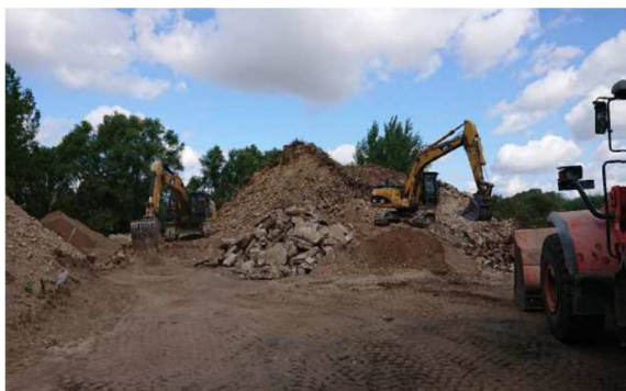
Sortierung des Bauschutts
