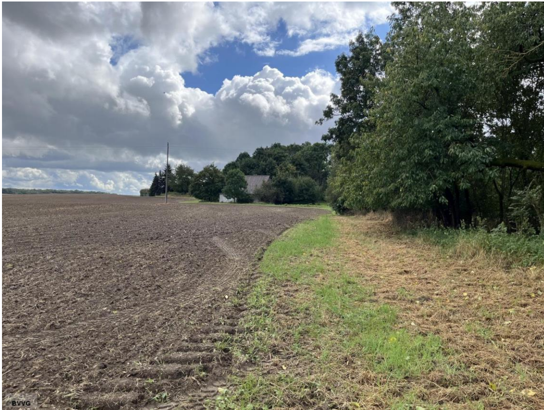
Blick zu den Flurstücken 92 und 93 - Freileitung mit Leitungsmast
